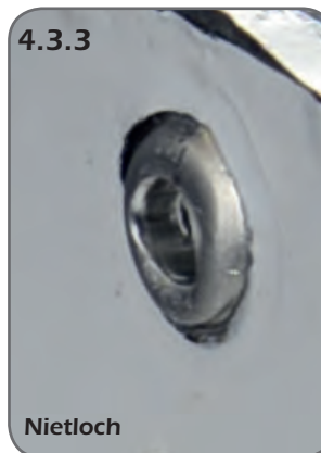
rückgeformtes Nietloch
